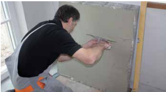
Fig. 11 – Spartling på bagsiden forhindrer indesluttet luft og optimerer vedhæftningen.
