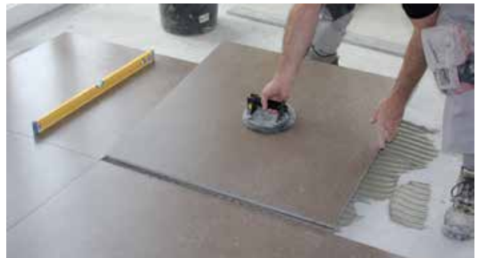
Fig. 12 – Lægning af en porcellanoflise i format 90 x 90 cm. Hjælpemidler som den her anvendte sugeløftekop letter arbejdet betydeligt.
