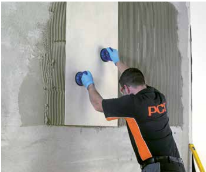
Fig. 2 – Fliser i stort format er ofte rigtige „sværvægtede“ ... Dette er dog ikke noget problem med den yderst stabile tyndlagsmørtel PCI FT® Flex!
