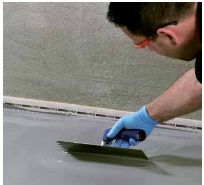
Fig. 4 – Med den let flydende udjævningsmasse PCI Periplan® Extra kan ujævne gulve nivelleres hurtigt og enkelt.
