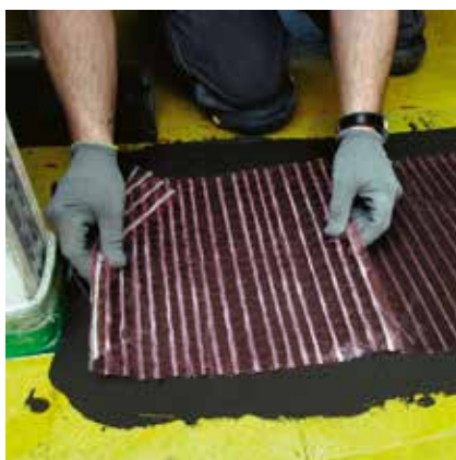
PCI Forstærkningsmåtte GFS lægges i den friske udjævningsmasse.
