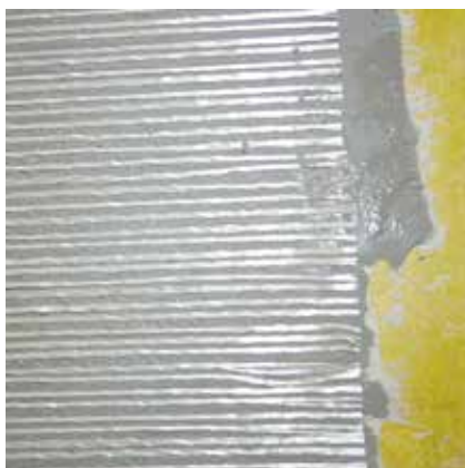
Den lagte PCI Forstærkningsmåtte GFS efter fjernelse af beskyttelsesfolien.
