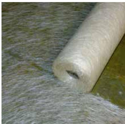
PCI Fibermåtte GFM rulles ud på det primede underlag.
