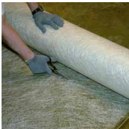
Tilskæring af PCI Fibermåtte GFM med saks.
