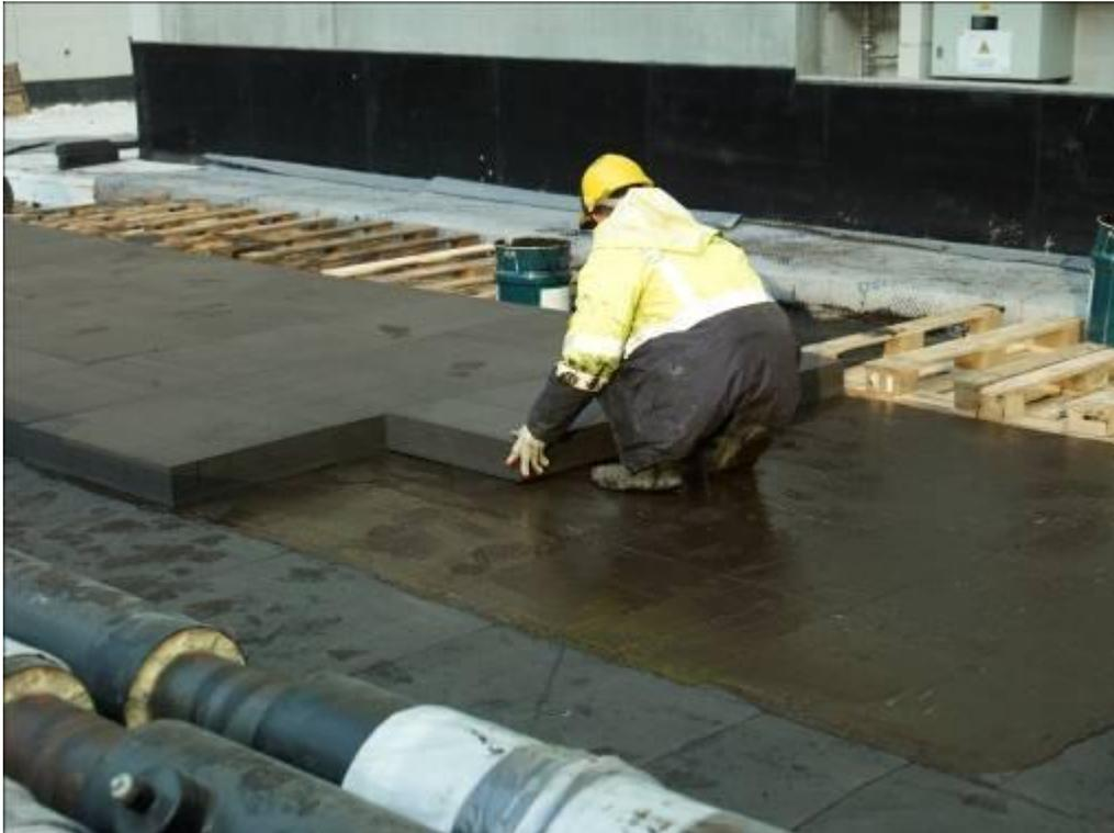
Die Glasschaumplatten wurden von November bis Dezember 2011 vollflächig mit dem zweikomponentigen Bitumen Dämmplattenkleber PCI Pecimor DK der PCI Augsburg GmbH überzogen und zusammengefügt. Ausgetretenes Material wurde einfach beigespachtelt. Die niedrigen Außentemperaturen verzögerten die Arbeiten nicht.
