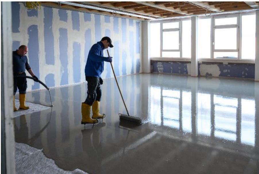
Leichte Verarbeitung, schneller Baufortschritt: PCI Periplan Extra verläuft sehr leicht und ist nach rund drei Stunden begehbar. (Link zum hochauflösenden Photo )
