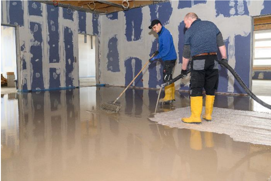
Zuverlässiger Bodenaufbau: glasfaserverstärkter Verbundausgleich mit PCI Amiermatte GFM und PCI Periplan Extra (Link zum hochauflösenden Photo )
