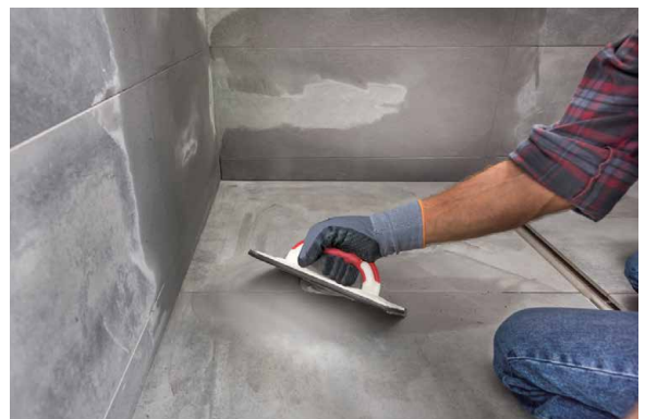
Smidig, enkel fugning med PCI Nanofug.
